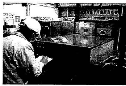
冷煤抽取作業查核
