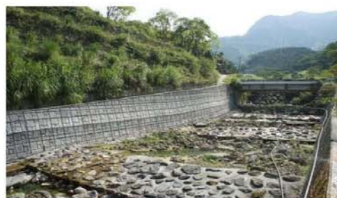
河道梳子壩及邊坡崩場地穩定
