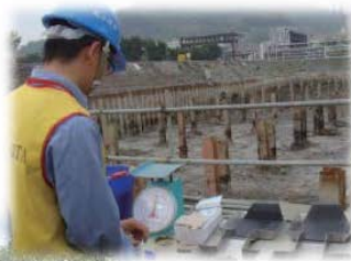
列管場址進行油水分離處理
