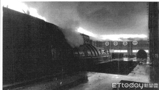
▲興達電廠汽機廠房。(圖/台電提供)
