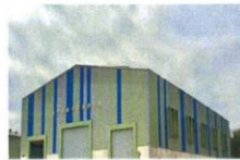
離島倉儲式機械分選廠 預計113年12月完工運轉
